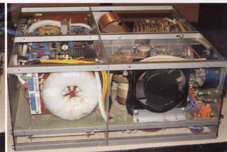
Vedere din stânga
