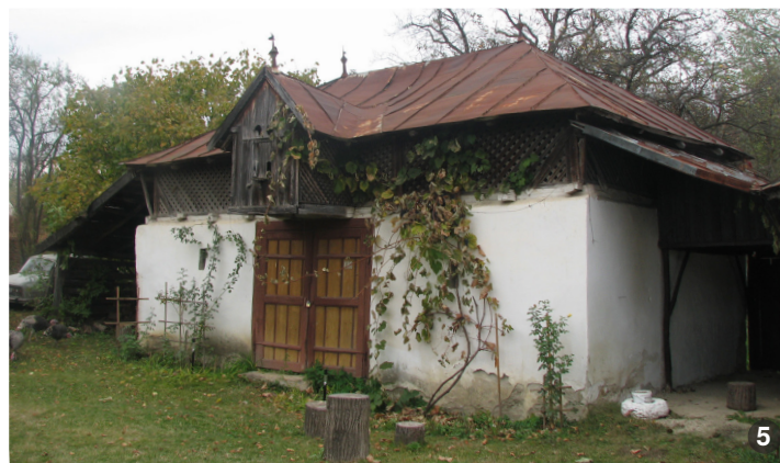
Clădire anexă cu partea inferioară din zidărie care permite izolarea termică iar partea superioară din lemn.
