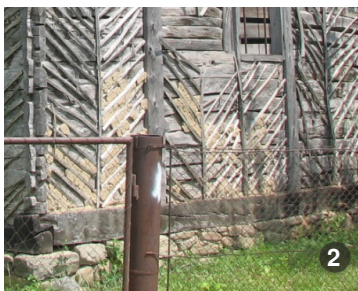
Perete de lemn cu tencuială de lut pe șipci.
