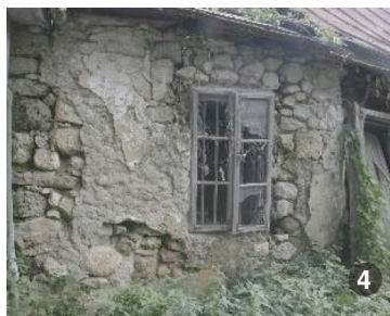
Zidărie din piatră.
