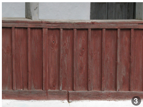
Parapetul poate fi zidit și vărut cu alb (la modelele cele mai vechi) sau poate fi din scânduri de lemn simple sau traforate.
