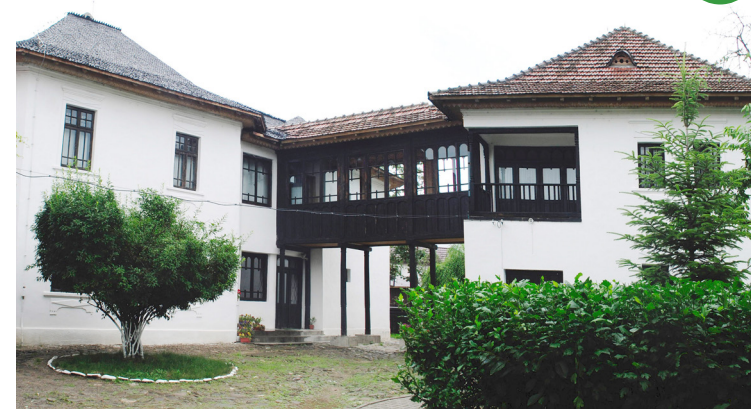
AȘA DA: Exemplu de corp de legătură între două clădiri. Corpul de legătură poate fi doar la parter sau, ca în acest caz, doar la etaj. De asemenea, exemplul de față prezintă zone vitrate cu ochiuri tradiționale de geam.
