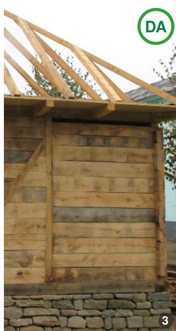
ASA DA: Construcție nouă cu structură din lemn și fundație din piatră.
