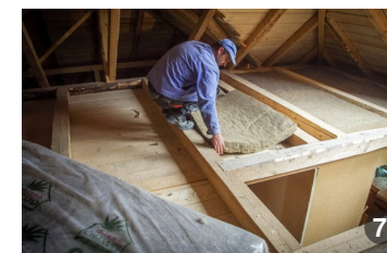
ASA DA: Termoizolația din lână este deosebit de recomandată. Folosirea unei izolații din lână sprijină o industrie a prelucrării produselor locale: în mod frecvent, lâna se aruncă, în loc să fie utilizată. Această măsură este încă la început în țara noastră, dar se folosește cu succes și pe scară largă în majoritatea țărilor europene.
