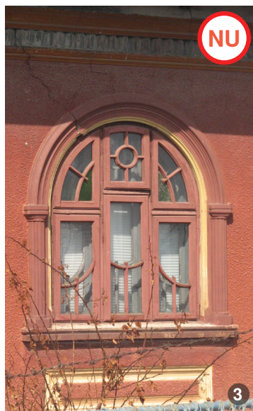
AȘA NU: Vopsirea tâmplăriei existente în alte culori decât cele naturale sau folosite în mod tradițional, duc la un aspect inestetic și în contradicție cu specificul local.
