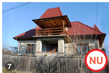
AȘA NU: Învelitoarea din tablă profilată nu se potrivește în contextul clădirilor tradiționale sau a construcțiilor noi din mediul rural chiar dacă se montează într-o culoare adecvată.
