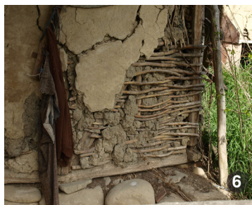
Detaliu de parament al unei case din lemn: tencuială din lut cu armătură din nuiile.
