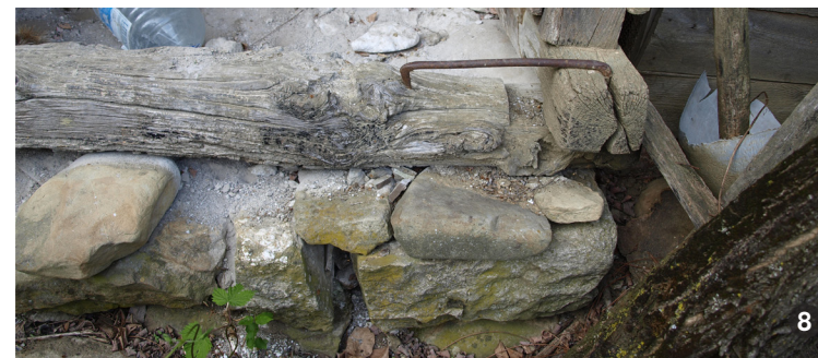
Fundație și soclu de piatră.
