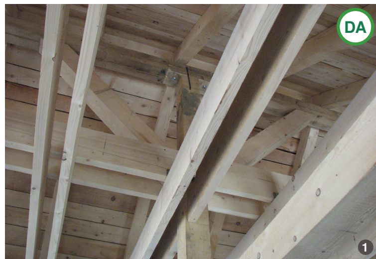
ASA DA: Utilizarea unei soluții locale de realizare a șarpantei. Astfel se susține economia locală, prin utilizarea forței de muncă și a materialelor din zonă.
