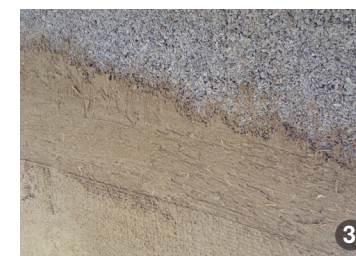
ASA DA: Pereți cu termoizolație din Hempcrete.
