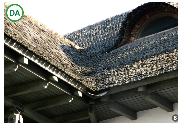
AȘA DA: Clădire nouă cu gabarit mare care poate constitui un mod de a acoperi construcții cu gabarit mare folosind acoperiș cu patru ape și învelitoarea din șindrilă.
