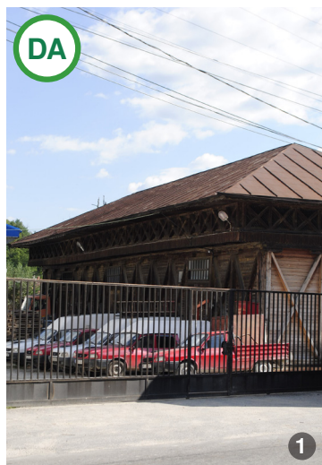
AȘA DA: Exemplu de construcție de gabarit mare, realizată din lemn având învelitoare din tablă fâltuită de culoare brun închis.
