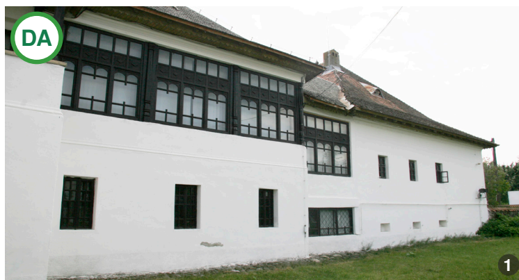
ASA DA: Golurile corespund necesităților de utilizare pentru construcții cu gabarit mare iar alternarea ferestrelor mici cu cele mari într-o alcătuire echilibrată
