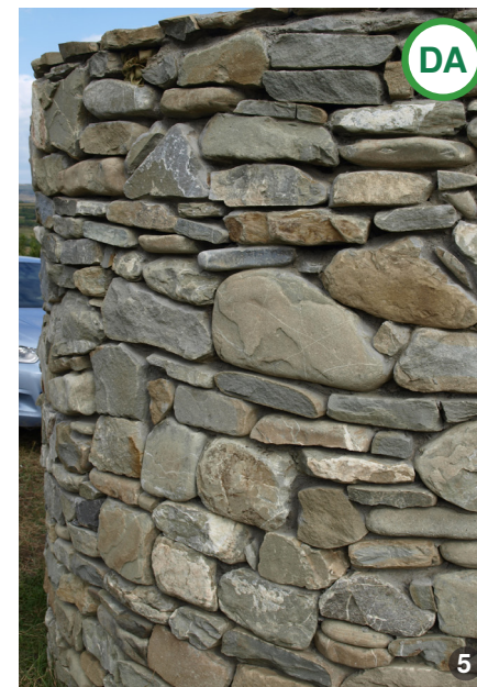
AȘA DA: În zonele cu acces facil la carierele de piatră sau la albiile râurilor, s-a folosit preponderent piatra pentru zidurile clădirilor și a zidurilor de sprijin.
