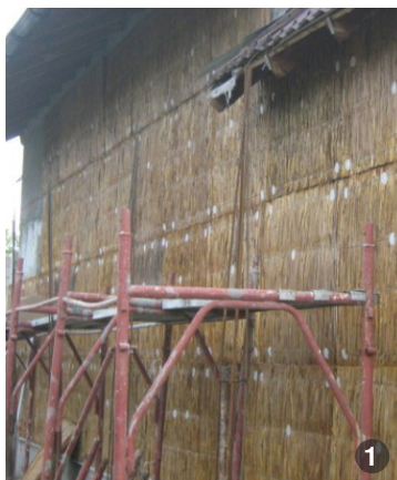
ASA DA: Exemple de pereți placați cu panouri termoizolante de stuf.
