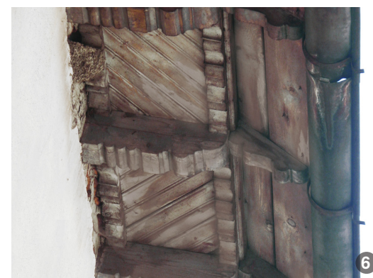
Modelele de case tradiționale cele mai vechi au streășină cu căpriori aparenti. La exemplarele începând cu sfârșitul secolului al XIX-lea streășina poate fi înfundată.
